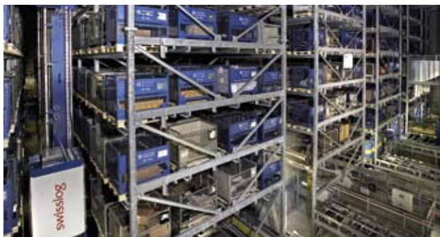
Blick in die Gasse eines vollautomatischen Palettenlagers.
